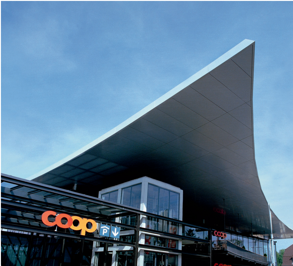
Stabil – großes, selbsttragendes Dach mit Verkleidung aus ALUCORE®
